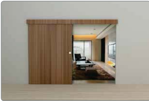
Instalação oculta, com tampa de cobertura em madeira.
